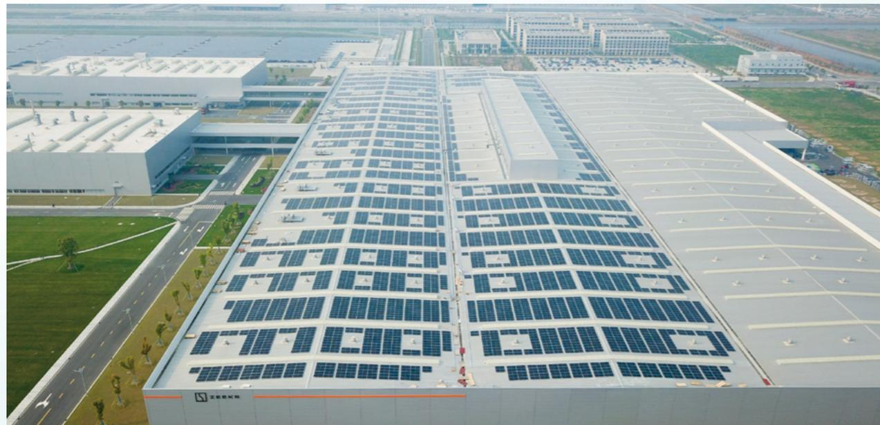
极氮工厂屋顶光伏装机容量达到 29.46 兆瓦，除光伏自发电外，2022 年将全部实施电力绿证采购
